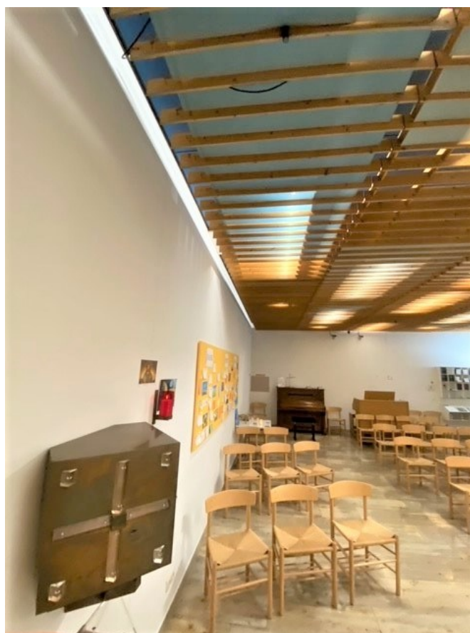
Kapelle der Kopfklinik: Frisch gestrichen, aber an der Decke gab es damals noch zu tun .... Inzwischen ist sie fertig. Foto: fn
